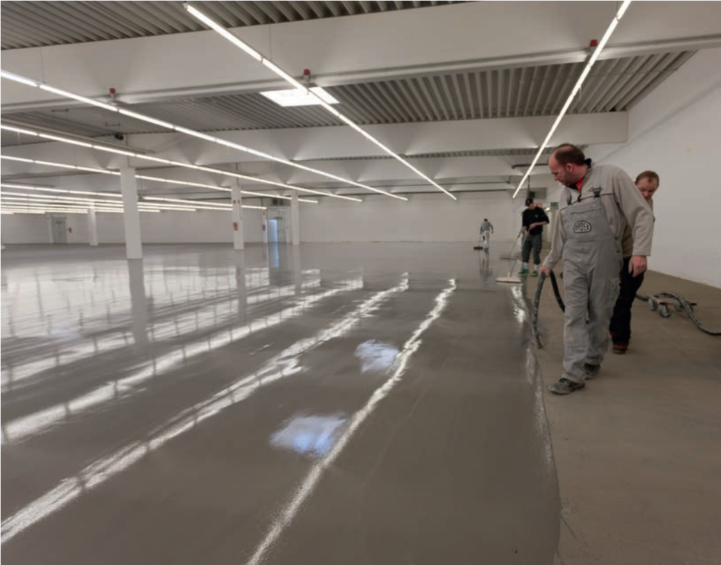
Bir antreпода ARDEX K 80 ince şap ile zemin yüzeyi oluşturuluyor.
