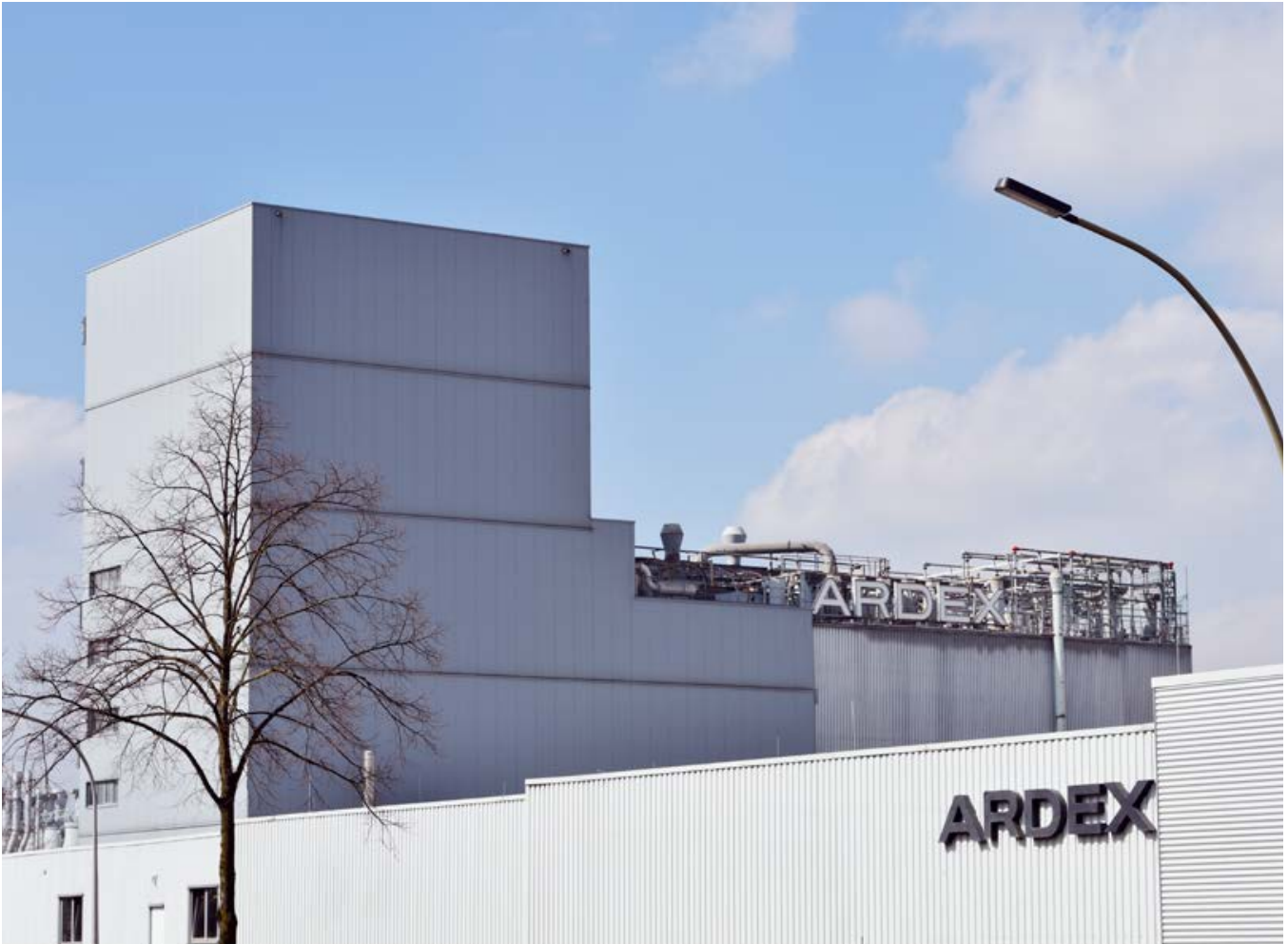
ARDEX-Werk in Witten (West-Ansicht), Deutschland
